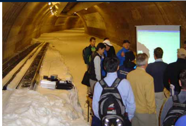
Tunnel avec piste de ski équipé de plateforme de force et avec consultation des résultats en temps réel
